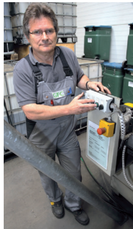
Die sortenreine Rückgewinnung der unterschiedlichen Kühlschmiermittel für das Schleifen und Fräsen wird durch das Umschalten eines Ventils an der Brikettierpresse ermöglicht.
