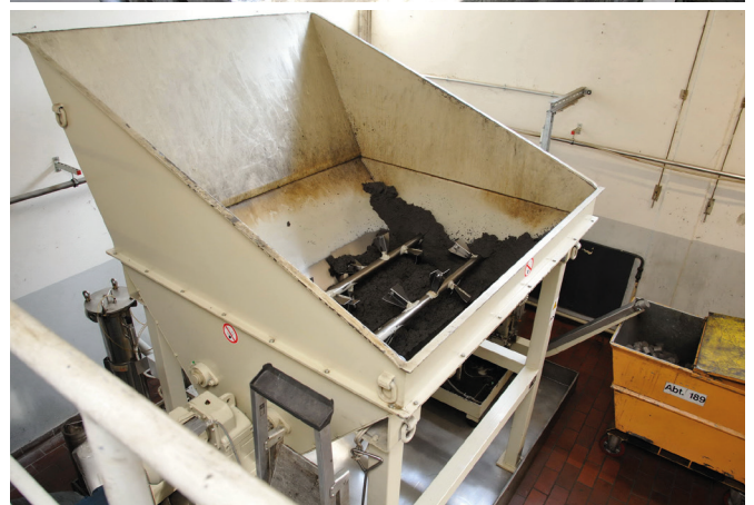
Der Schleifschlamm aus der Stahlbearbeitung wird in 0,4 Kubikmeter fassenden Behältern (oben im Werk Thyrnau / unten im Passauer Werk 1) zur Brikettierpresse transportiert und per Gabelstapler in den Vorratstrichter der Anlage gefüllt.
